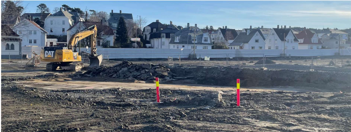
Figur 3. De sentrale områdene på Flotmyr har store setninger og flere lag med asfalt vitner om gjentatte tilnærminger til å avrette overflaten.
