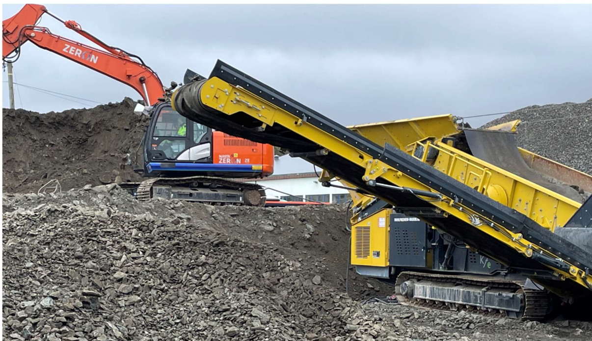
Figur 7. Vassbakk & Stol har en helelektrisk sorteringslinje med 16/18 tonns EL-graver og elektrisk sikteverk. Sikteverket sorterer oppgravde masser slik at steinmasser kan gjenbrukes og uegnede masser kan transporteres til godkjent mottak.
