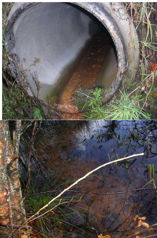
Figur 10 Tilførsel av forurenset vann til dam S1. Det brune belegget består delvis av metallutfellinger. Bildet nederst viser tilsvarende utfellinger på dambunnen. Foto: Karl Otto Mikkelsen
