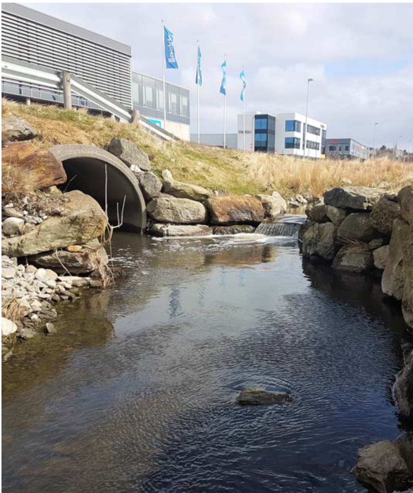
Figur 7-5 Åpning av Sakkestadbekken, fellesprosjekt med Karmøy kommune
