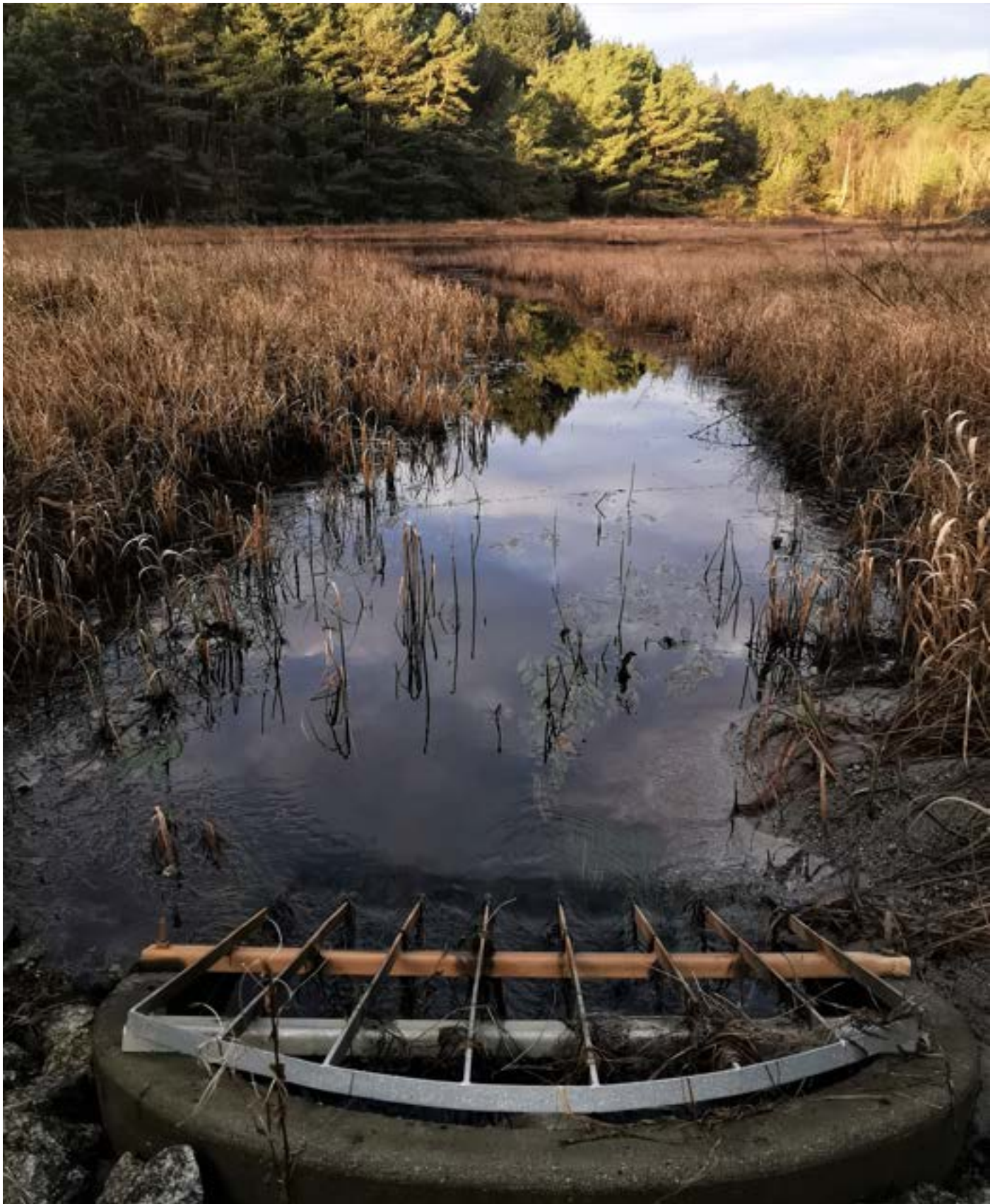
Figur 7 6 Villduen, bekkeinntak med rist
