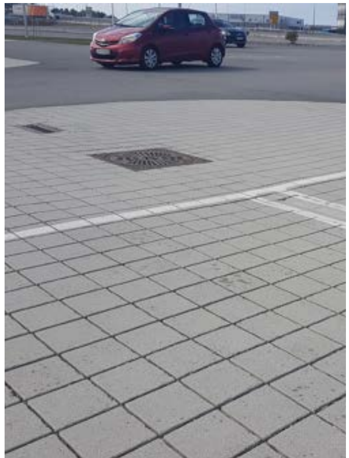
Figur 7-4 Permeabel overflate, parkeringsareal Obs Bygg.
